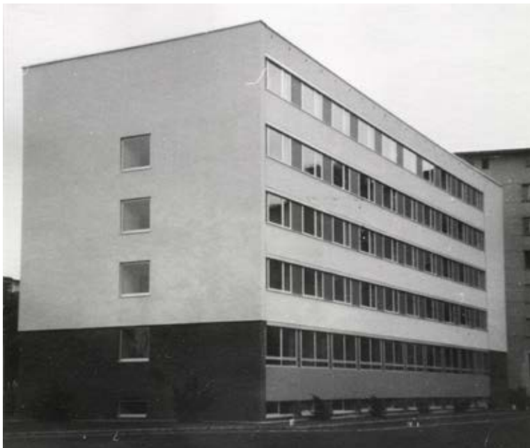
Bau der Krankenpflegeschule, Beginn der Inneneinrichtung im September 1969.
