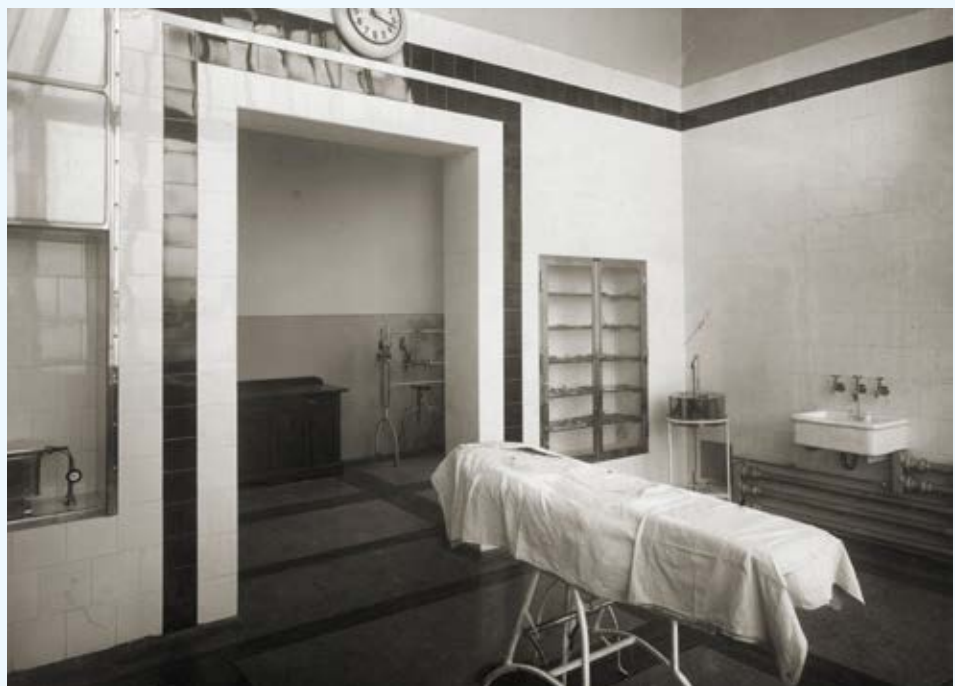
Der Septische Operationssaal.
