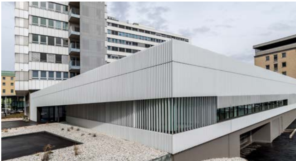
Architektonisch wie medizinisch der Ausdruck von Modernität – das Gebäude des Tagesklinischen Zentrums am Gelände des Klinikums, eröffnet im Jahr 2018.
