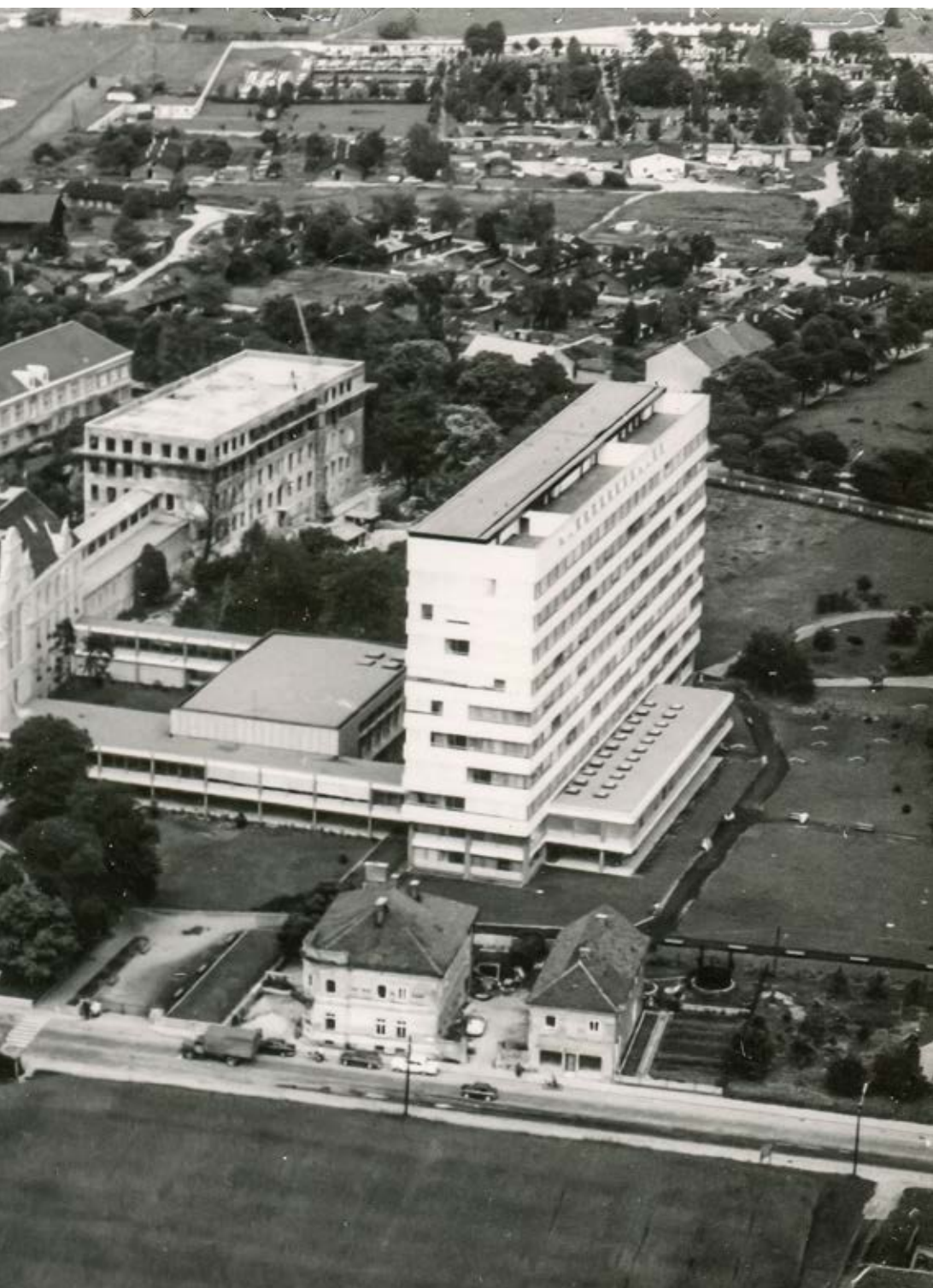
Krankenhaus mit Bettentrakt I.
