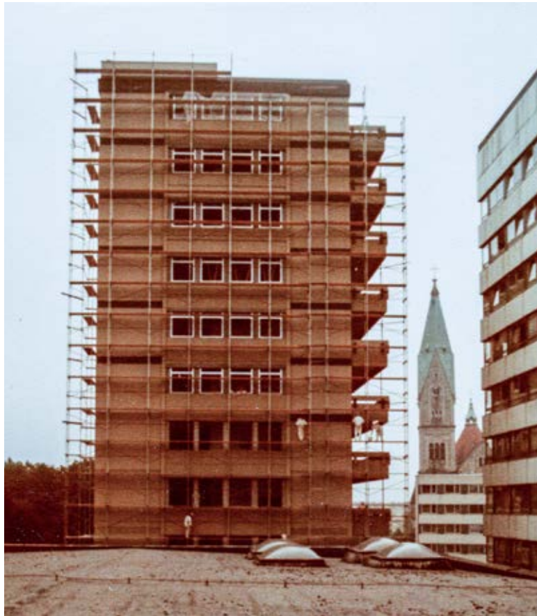
Ein gewohntes Bild, die Dauerbaustelle Krankenhaus Wels. Fertigstellung der Fassade des Bettentrakts II im Jahr 1977.
