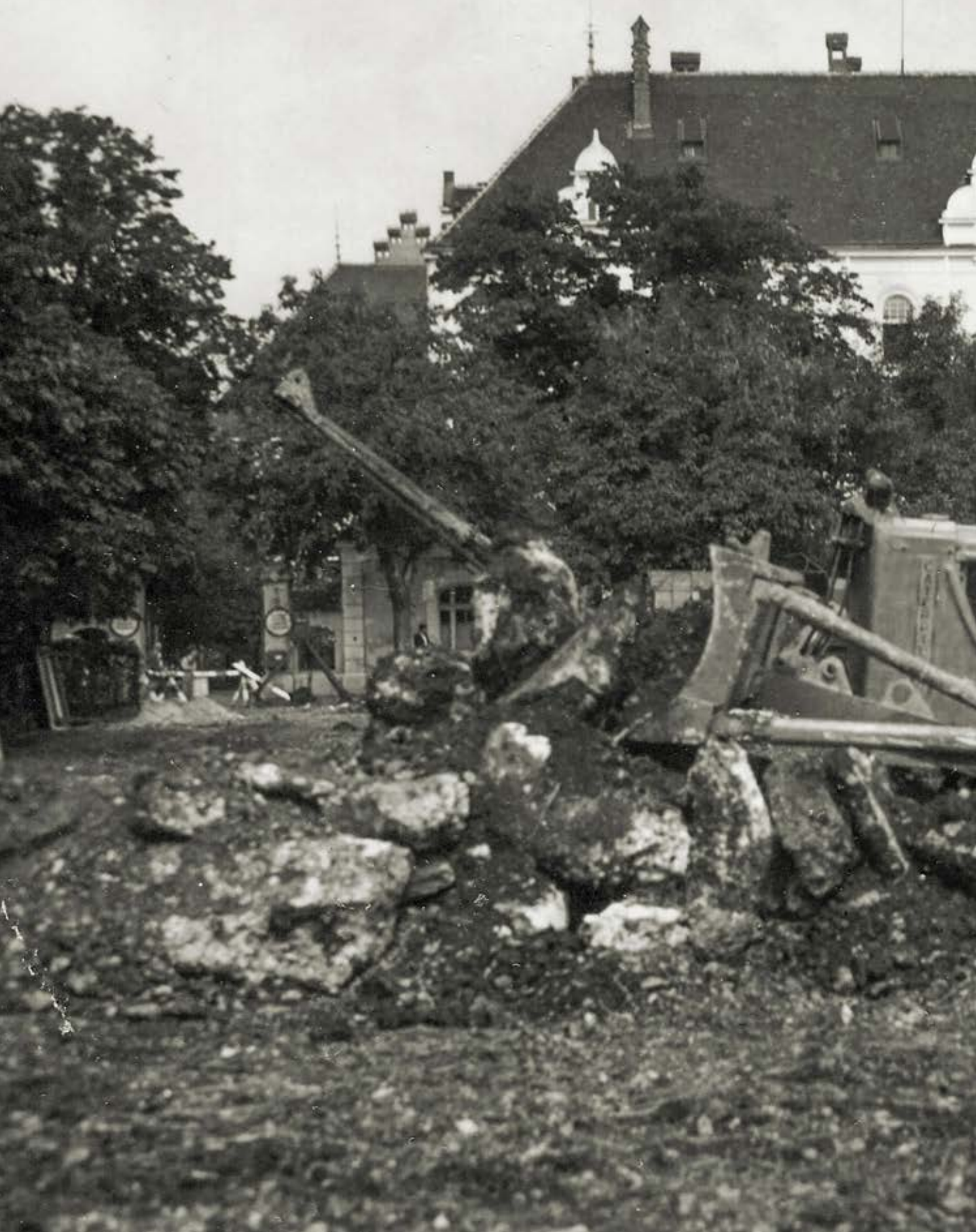
Mit schwerem Gerät wurde das Areal des ehemaligen Luftwaffen-Lazarets im Jahr 1952 von den noch verbliebenen Trümmern befreit.
