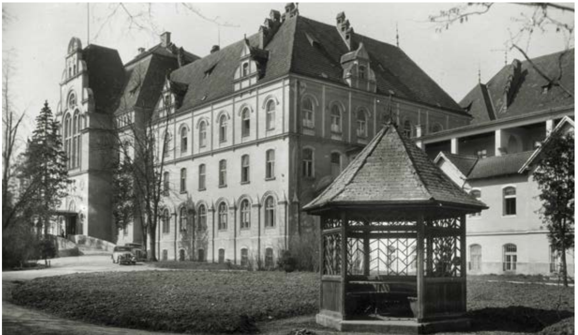
Die bedeutende Stellung der Ärzteschaft und die Würdigung ihrer Arbeit durch den Konvent verdeutlicht die Errichtung eines Pavillons im Garten des Krankenhauses im Jahr 1926. An diesem Ort verbrachten die Ärzte oft ihre wohlverdienten Pausen.
